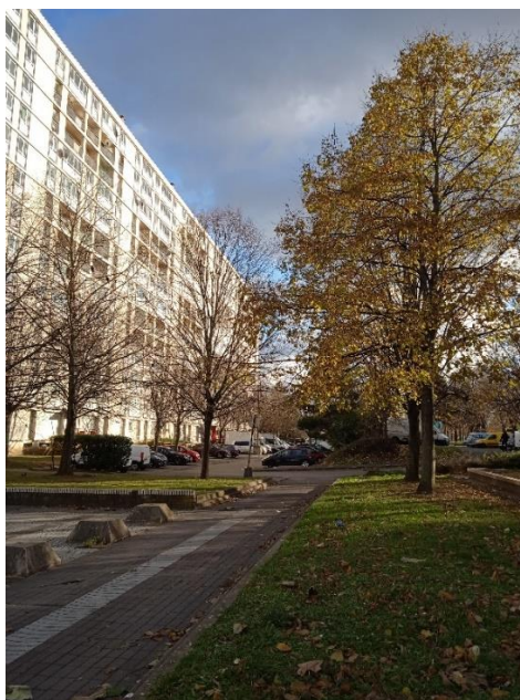
Aux navigateurs, le bâtiment Jacques Cartier en novembre 2021
